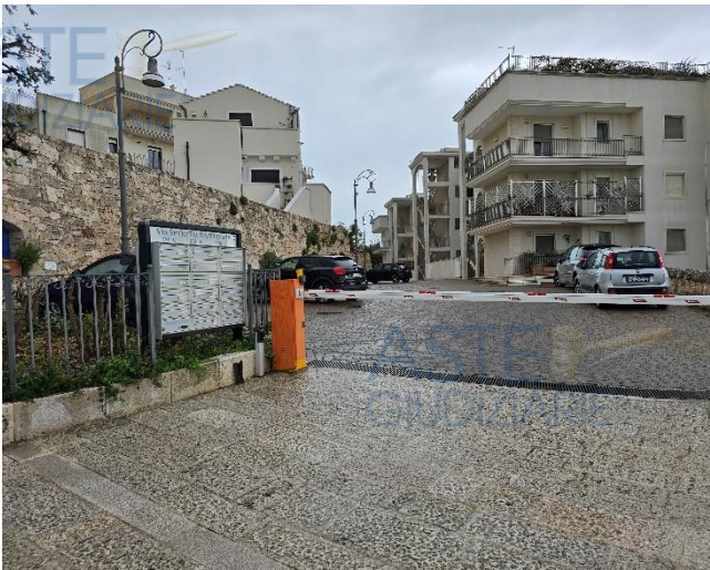
Foto 1 – Ingresso complesso residenziale
