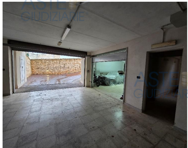
Foto 4 – Ingresso piano seminterrato
