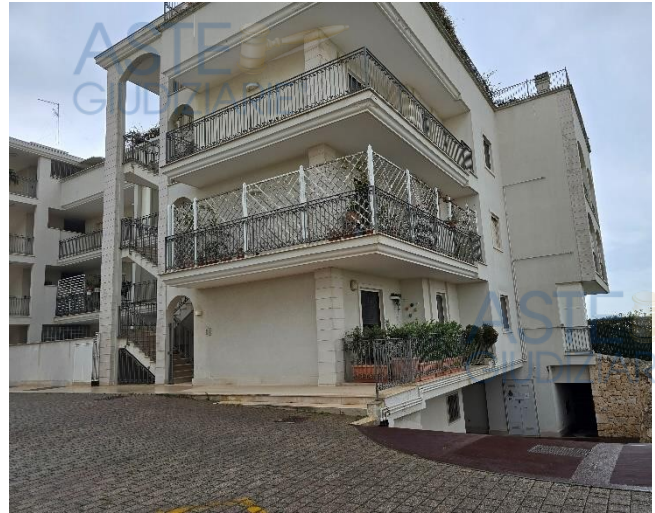
Foto 2 – Prospetto palazzina C
