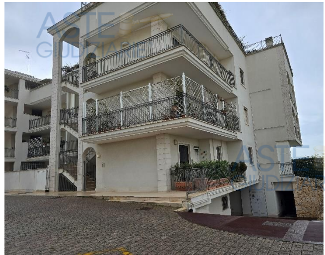
Foto 2 – Prospetto palazzina C
