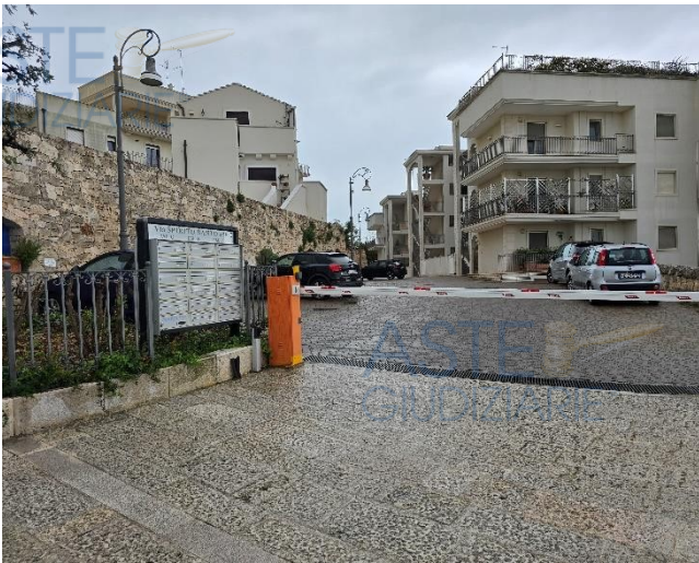
Foto 1 – Ingresso complesso residenziale
