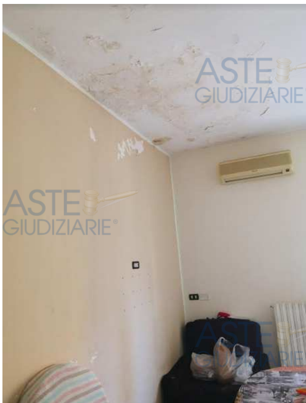
Foto 2: Particolare intradosso solaio sala pranzo
