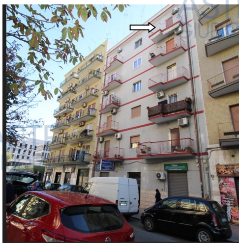
Fig. 2) Prospetto del fabbricato su Corso Italia – La posizione dell'appartamento è indicata dalla freccia
