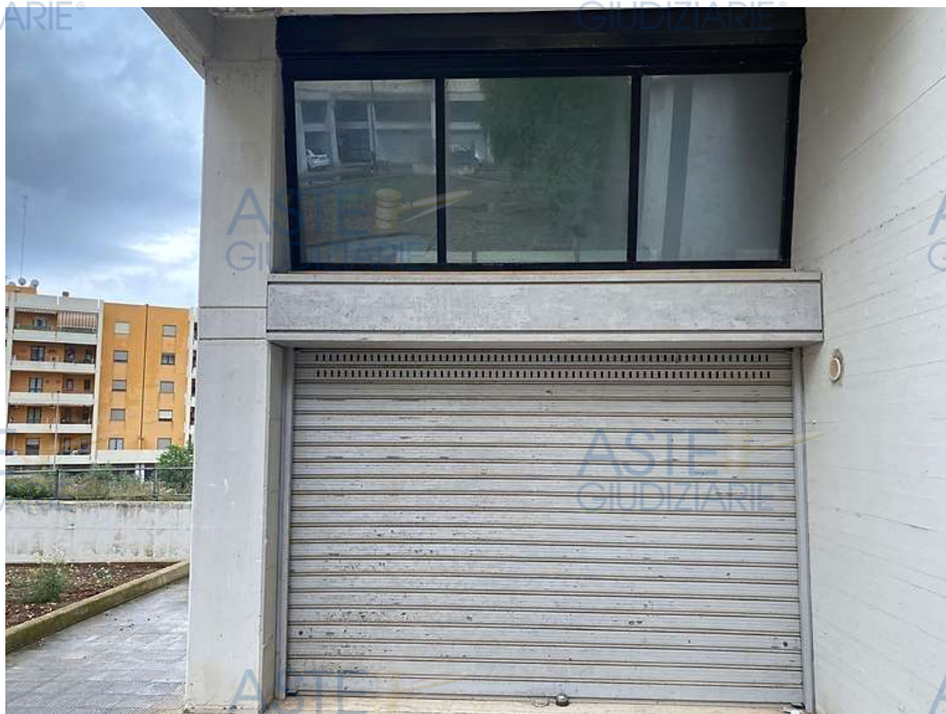
Figura 4 – Ingresso e Prospetto Est su [REDACTED]
