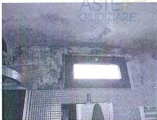
FOTO – infiltrazioni al piano seminterrato
