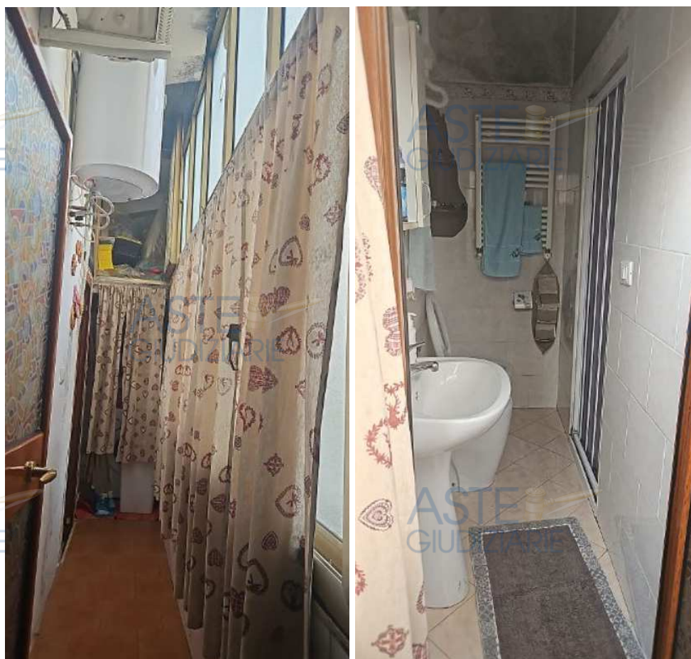
Foto 4 – Balcone cortile interno (particolare ripostiglio e bagno)
