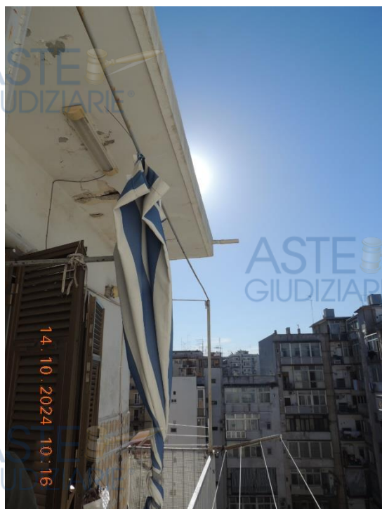
Foto 7 – Particolare della soletta a sbalzo
