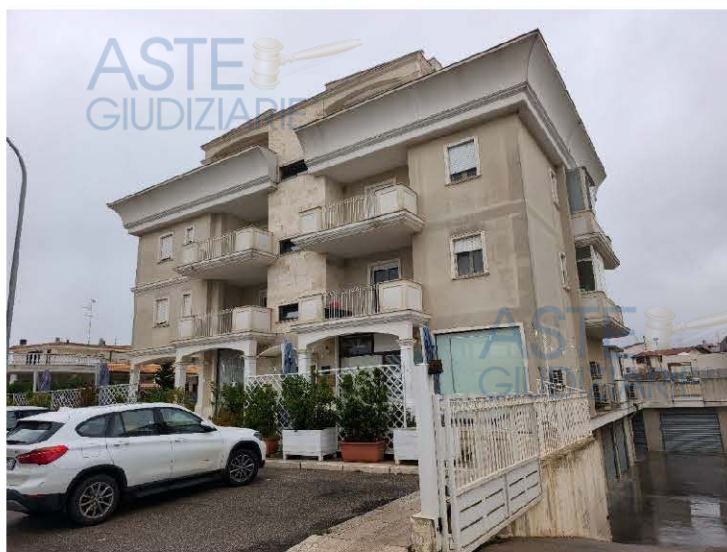
Fig. 7) Prospetto del fabbricato su Via Giuseppe Russi con la rampa di accesso al piano interrato a destra
