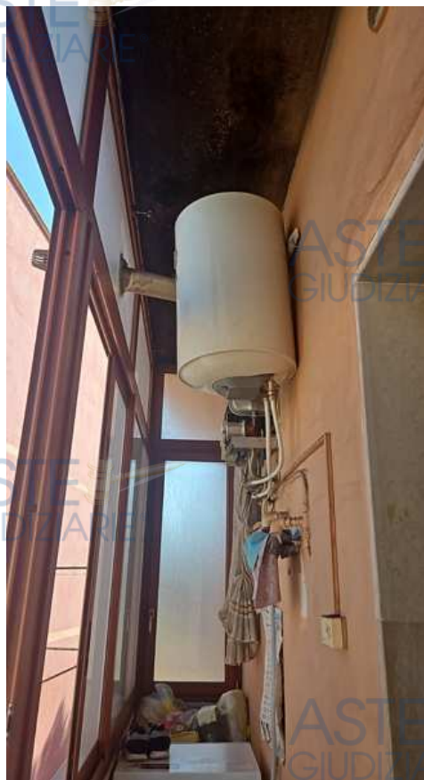
Foto 4 – Balcone/veranda via De Vincentiis
