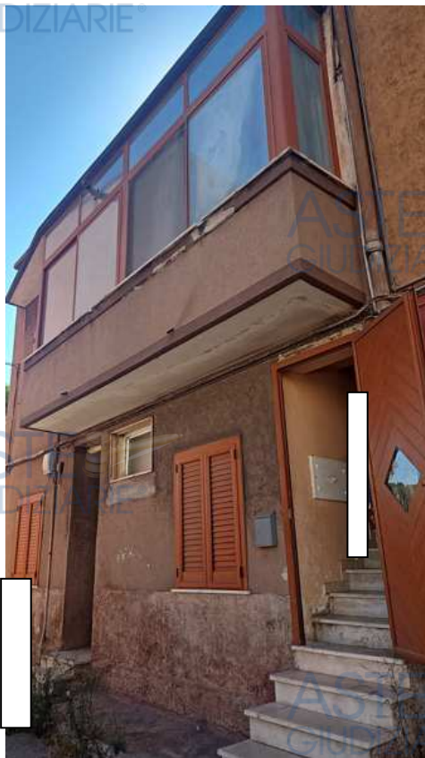
Foto 9 – Prospetto via De Vincentiis
