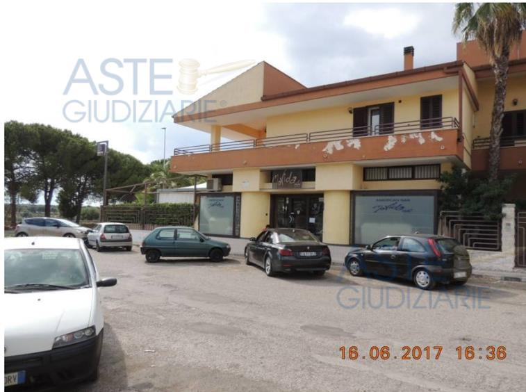
**FABBRICATO:** L'immobile adibito a bar è parte di un fabbricato composto da un piano terra e un piano superiore, realizzato con struttura portante in cemento armato e orizzontamenti in sidero-latero-cemento. Lo stabile versa in normale stato di conservazione.
