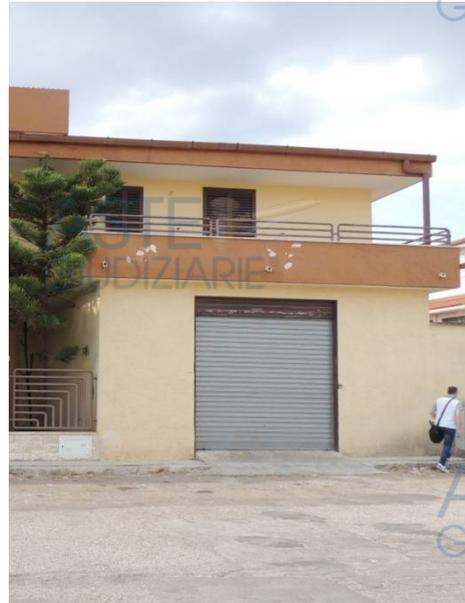
**FABBRICATO:** L'immobile è parte di un edificio a due piani fuori terra, realizzato con struttura portante in cemento armato e orizzontamenti in sidero-latero-cemento. Lo stabile versa in mediocre stato di conservazione.
