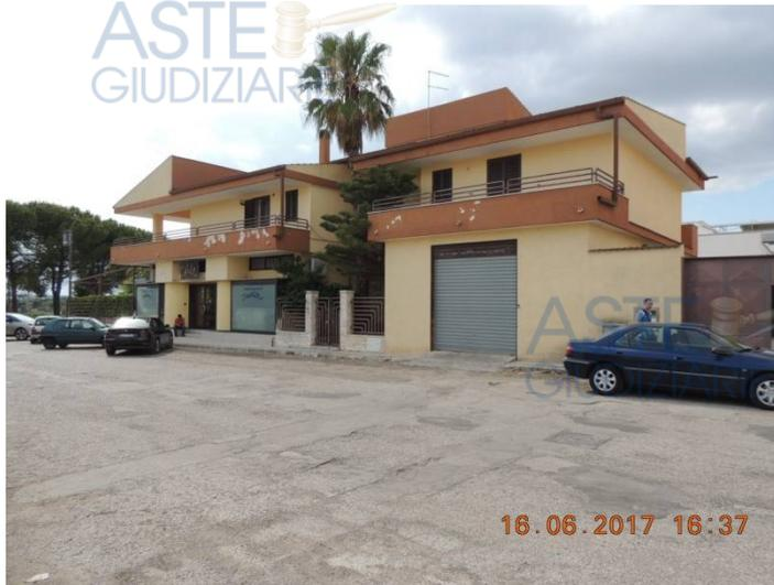
**FABBRICATO:** L'immobile è parte di un edificio a due piani fuori terra, realizzato con struttura portante in cemento armato e orizzontamenti in sidero-latero-cemento. Lo stabile versa in mediocre stato di conservazione ed è privo di impianto di ascensore.
