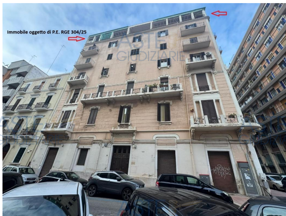
Prospetto principale, Via Mazzini, 21
