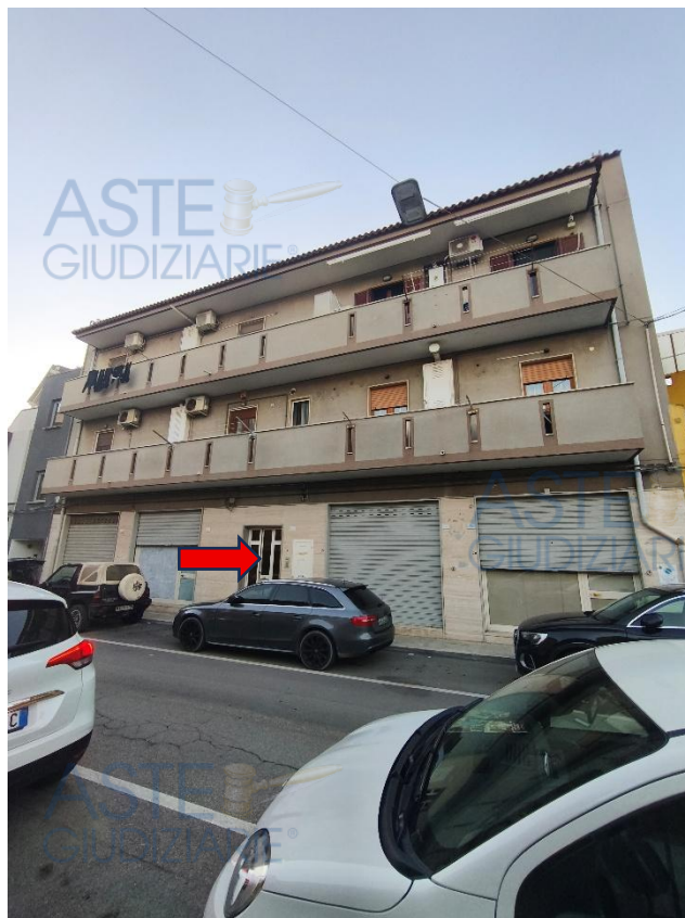
Fig. 3) Prospetto del fabbricato su Via San Nicola – L'accesso all'androne ed alla scala che conducono all'appartamento oggetto di esecuzione è indicato dalla freccia rossa
