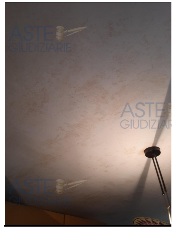
29. 1°P – Dettaglio intradosso solaio
