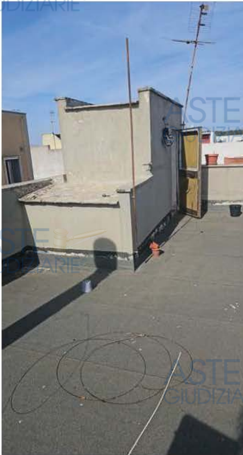
Foto 4: Vano tecnico e terrazzo
