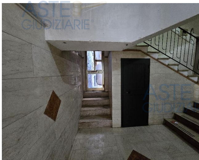
Foto 4 – Androne ingresso condominiale
