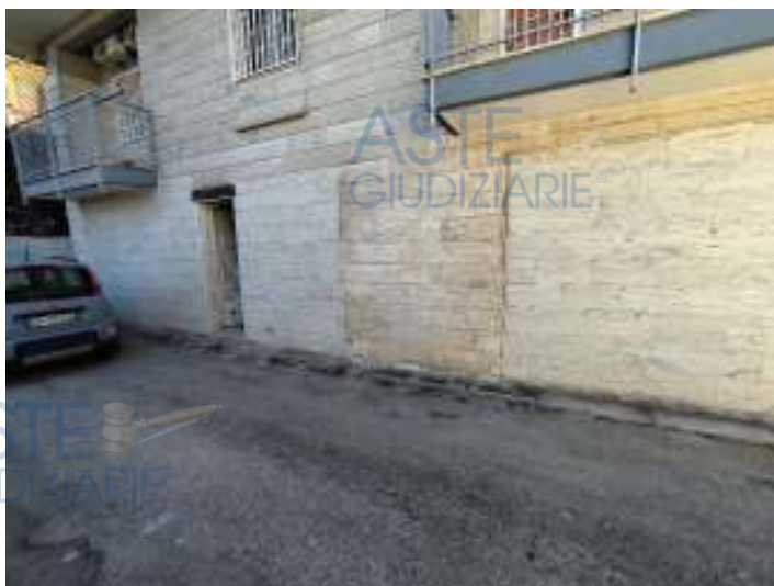
Foto 35- Esterno del fabbricato: piano interrato adibito a cortile/posti auto (vista del fronte Nord-Est)
