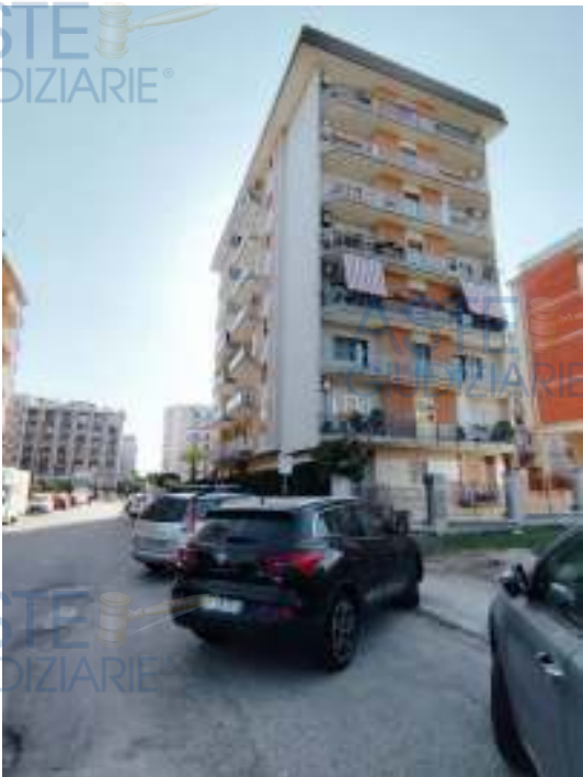
Foto 3- Vista particolare del fabbricato da via A. Savinio (Nord-Est)
