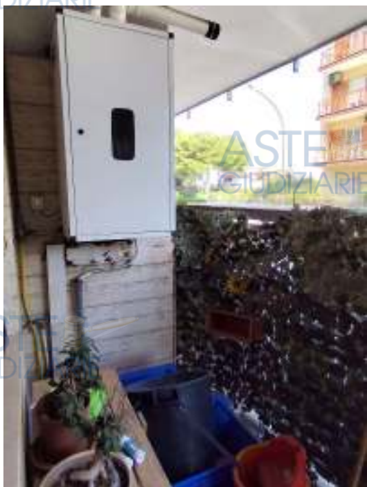
Foto 30- Balcone (vista verso Nord-Est)
