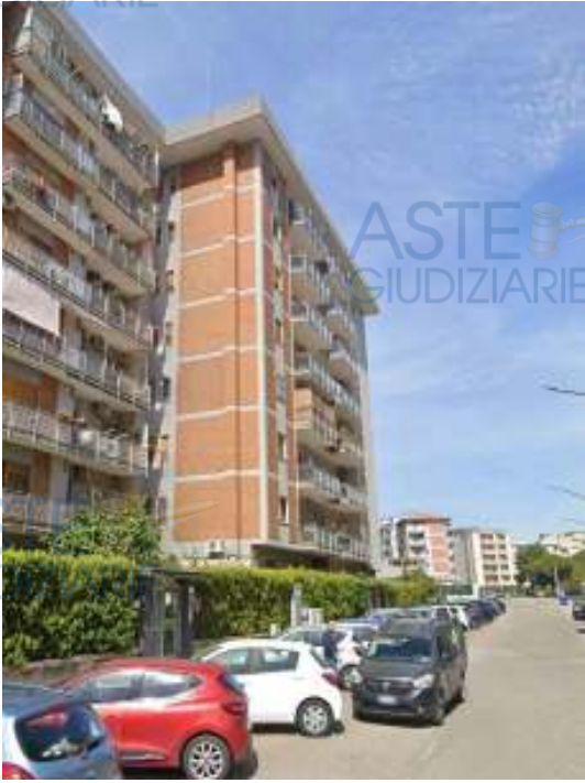
Foto 1- Vista d'insieme del fabbricato da Corso Italia (Sud-Ovest)
