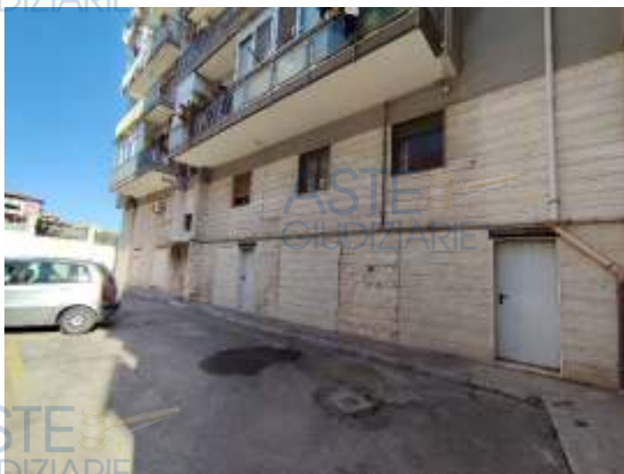
Foto 33- Esterno del fabbricato: piano interrato adibito a cortile/posti auto (vista verso Nord-Est)
