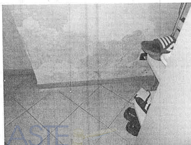
FOTO - pitturazione e intonaco danneggiati da umidità di risalita
