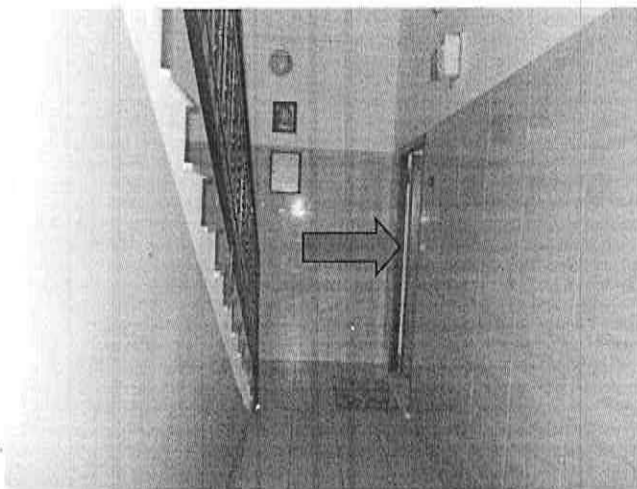
FOTO – vano scala
