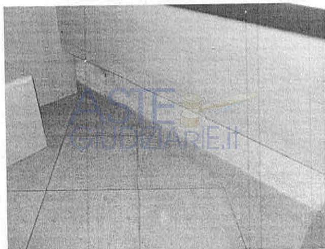
FOTO - pitturazione e intonaco danneggiati da umidità di risalita
