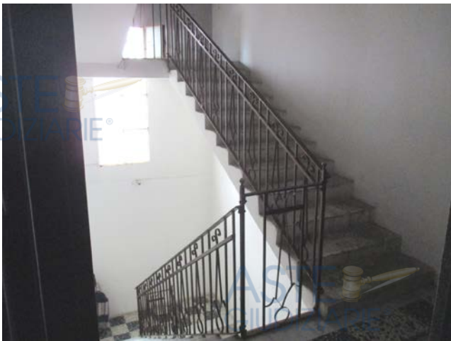
FOTO - vano scala
