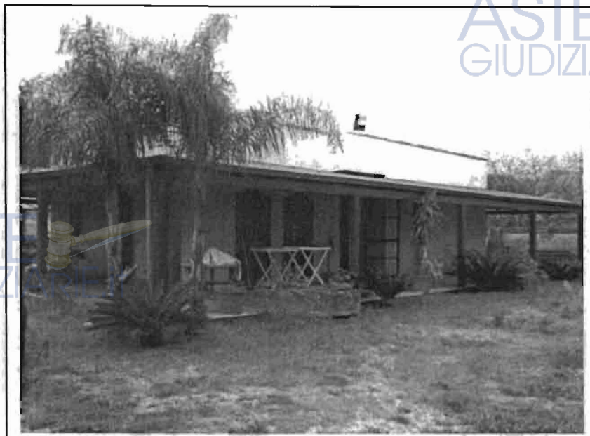
(Prospetto Ovest del fabbricato)
