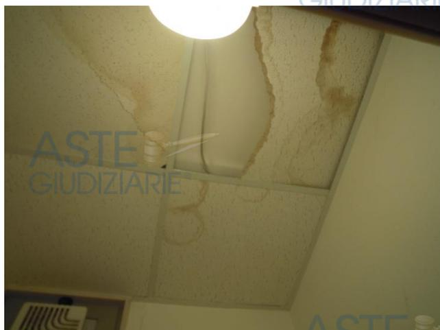
Fig. 32) *Tracce di infiltrazioni da acque meteoriche sul controsoffitto del bagno*
