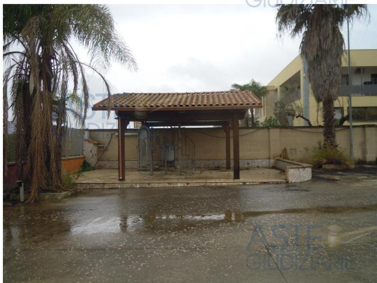
*Fig. 31) Tettoia da esposizione in alluminio e legno lamellare*
