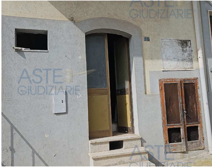
Foto 1 – Prospetto esterno Lotto Uno
