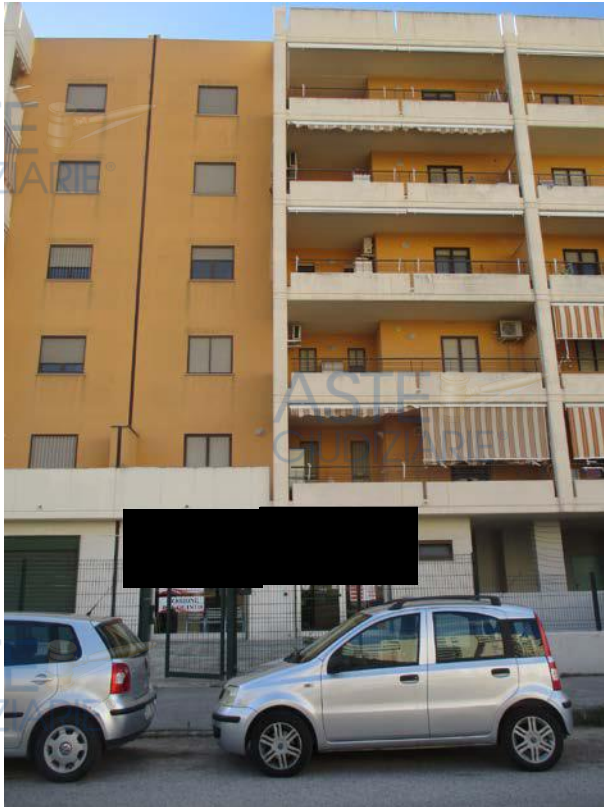
FOTO – vista del fabbricato
