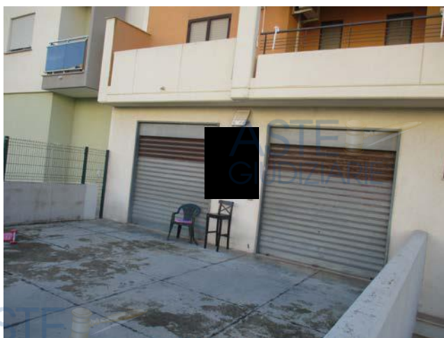
FOTO – viste del locale
