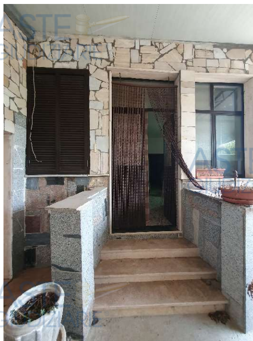
Foto 17 – Ingresso sul retro
