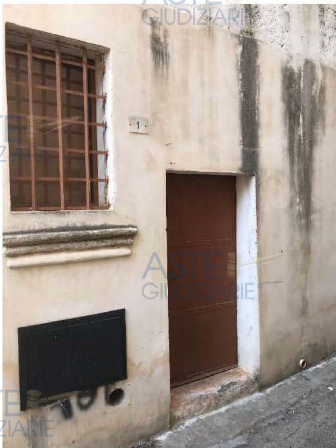
Foto 1 - Prospetto principale via R. Elena 1
