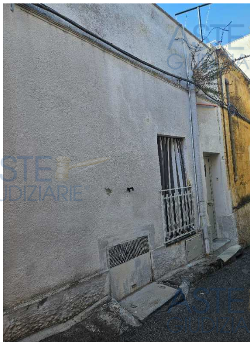
Foto 5 – Stato conservativo esterno
