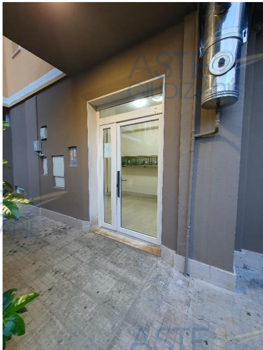
Foto 3 – Ingresso scala A
