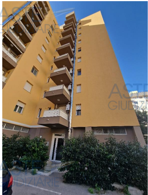
Foto 2 – Ingresso scala A
