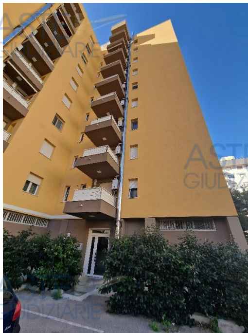
Foto 2 – Ingresso scala A
