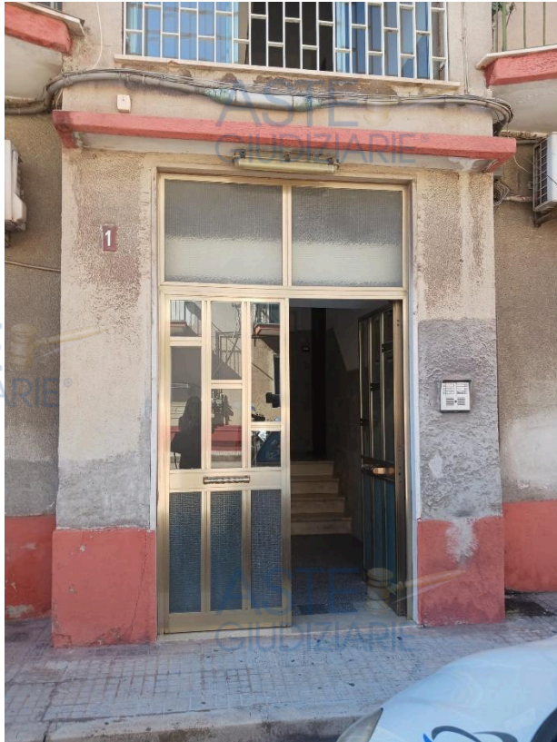
1. Portone d'ingresso condominiale
