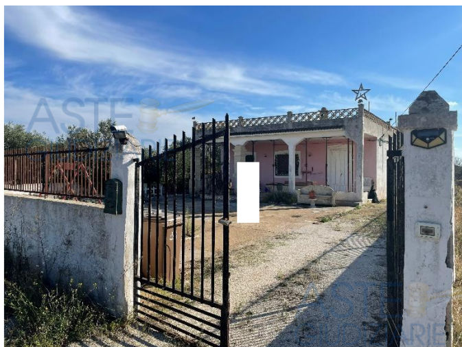
Ingresso immobile da strada interpoderale
