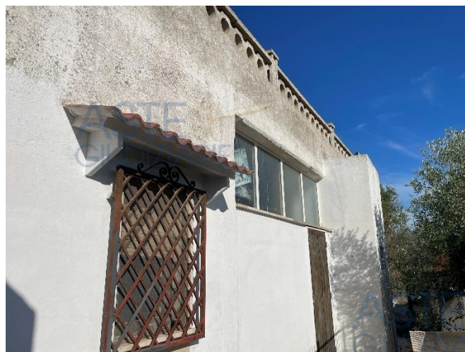
Esterno - lato SUD
