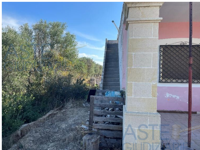
Esterno - lato EST
