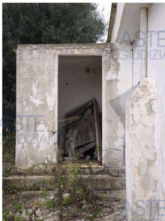
Fig. 34) Foto del w.c. attiguo al vano deposito del fabbricato censito al C.F. del Comune di Castellaneta al Foglio 97 part. 93 sub. 1
