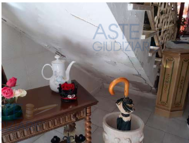
FOTO – scala per il lastrico solare
