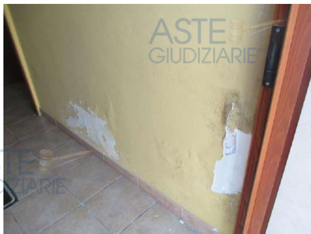
FOTO – umidità da risalita capillare e condensa
