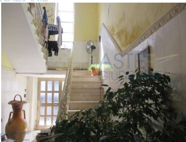
FOTO – vano scala
