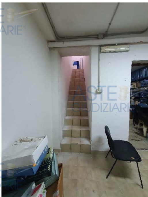
Foto 11 – Locale piano seminterrato
