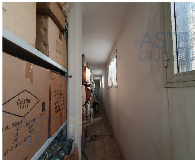
Foto 14 – Locale piano seminterrato
