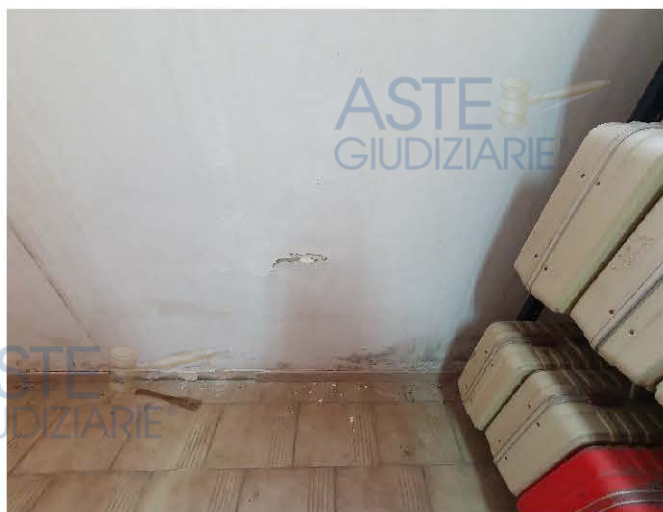
Foto 15 – Locale piano seminterrato
