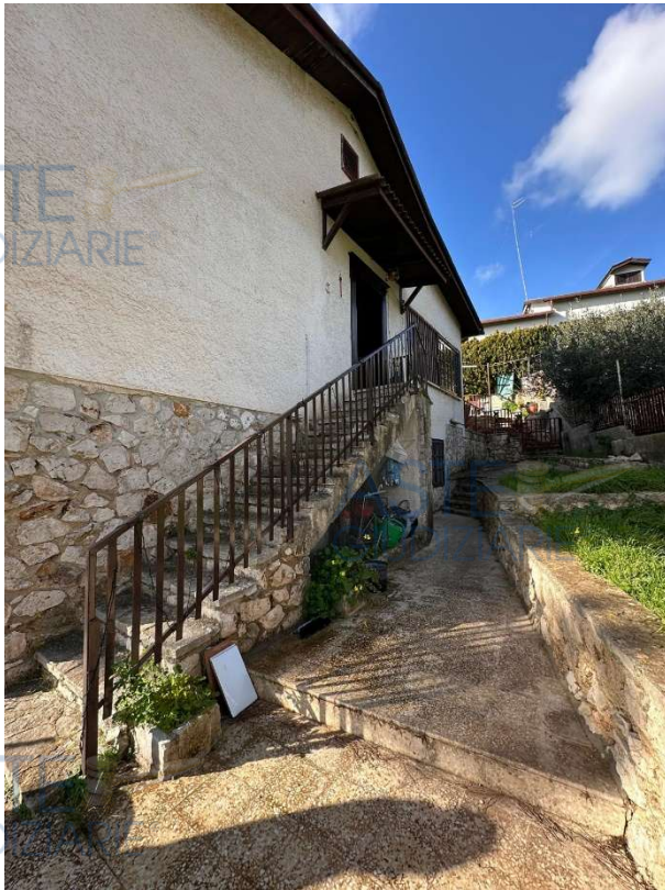
Foto 3 – scala di accesso
