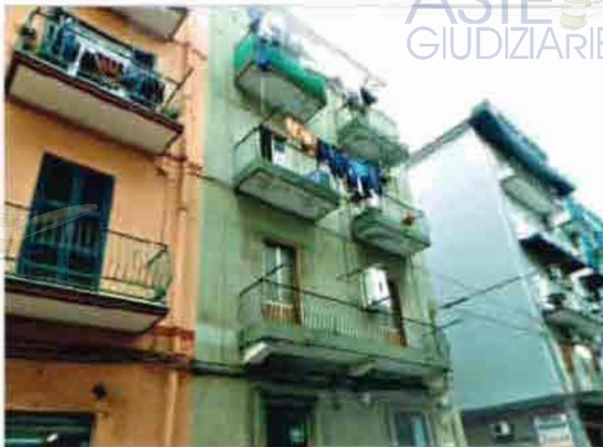
Taranto - foglio 203 - p.lla 3129 - sub 5 - fabbricato in via Leopardi n. 70 - piano terra e tre piani superiori
