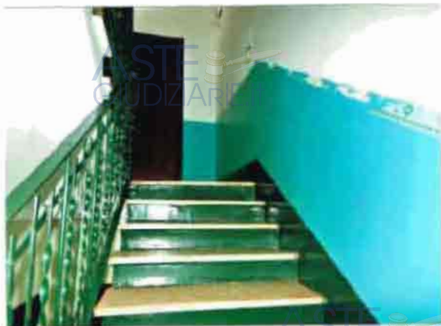
Taranto - foglio 203 - p.lla 3139 - sub 0 - via Leopardi n. 70 - terzo piano, porta a sinistra salendo le scale - vano scala
