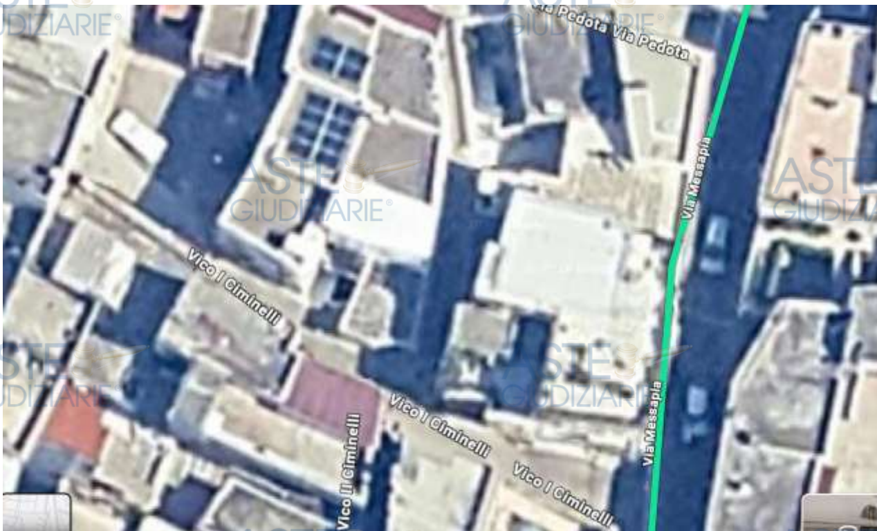
Fig.2 Ortofoto ricavata da Google Earth con indicazione VICO I CIMINELLI n. 18/22
