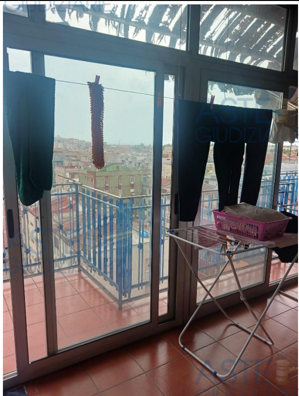
14. Veranda prospiciente via Grazia Deledda chiusa con vetrate
