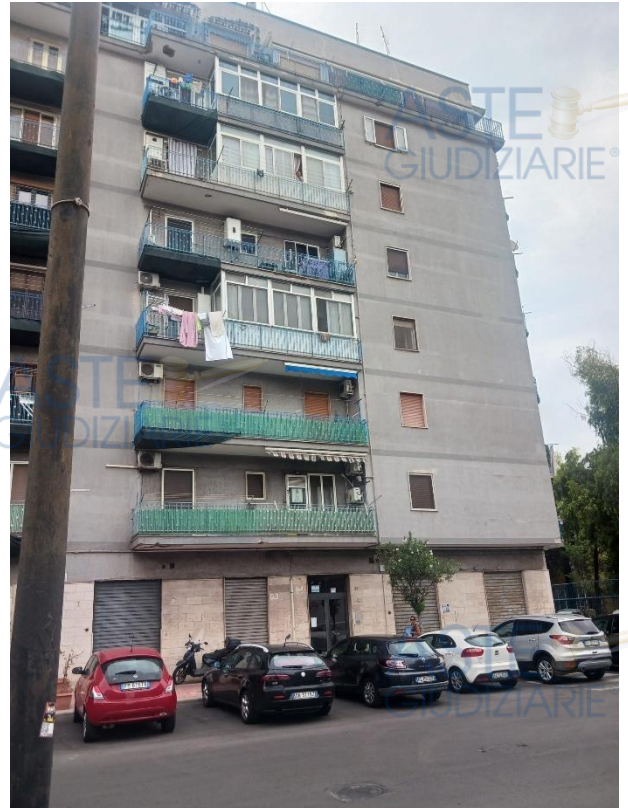
2. Prospetto della palazzina prospiciente via Grazia Deledda
