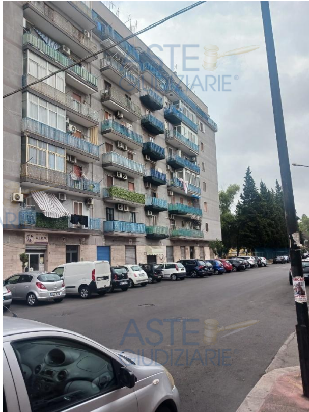
1. Prospetto della palazzina prospiciente via Grazia Deledda
