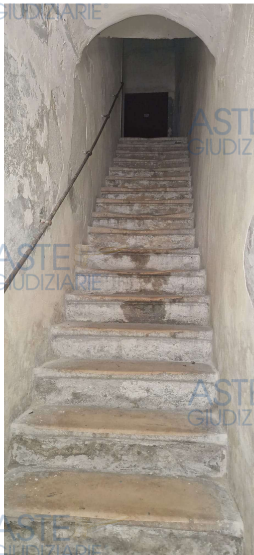
Particolare Ingresso vano scala
