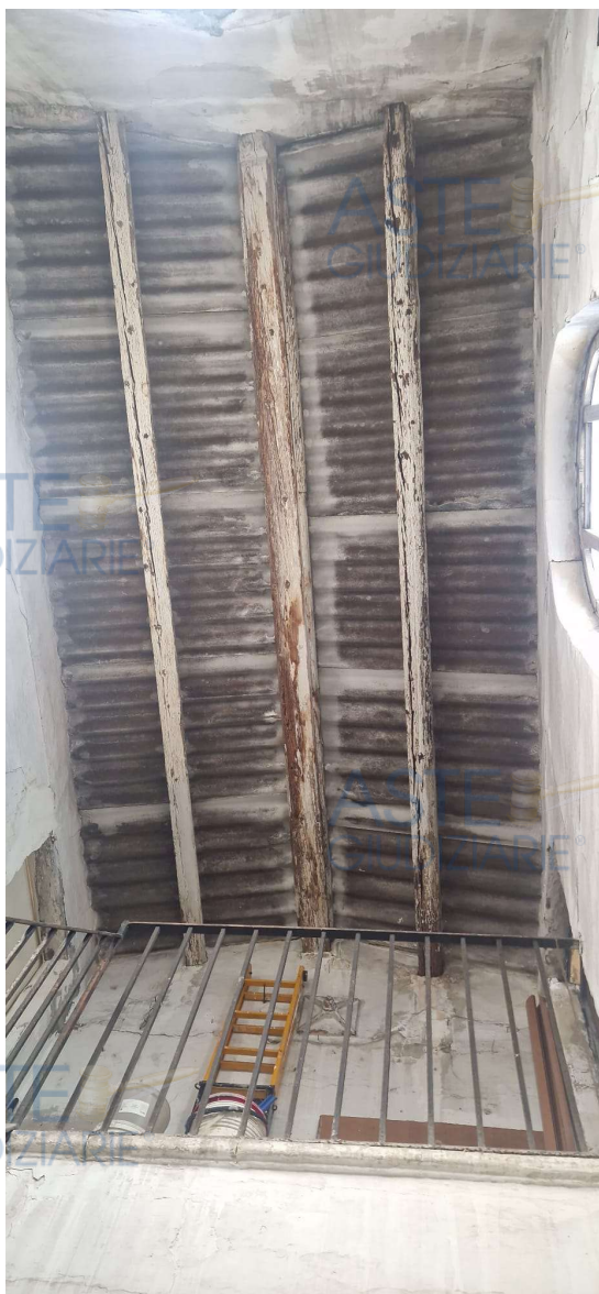
Particolare copertura vano scala
