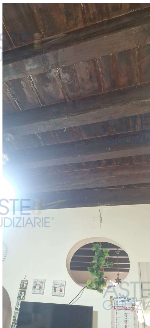
Foto 3 – dettaglio solaio in legno zona giorno
