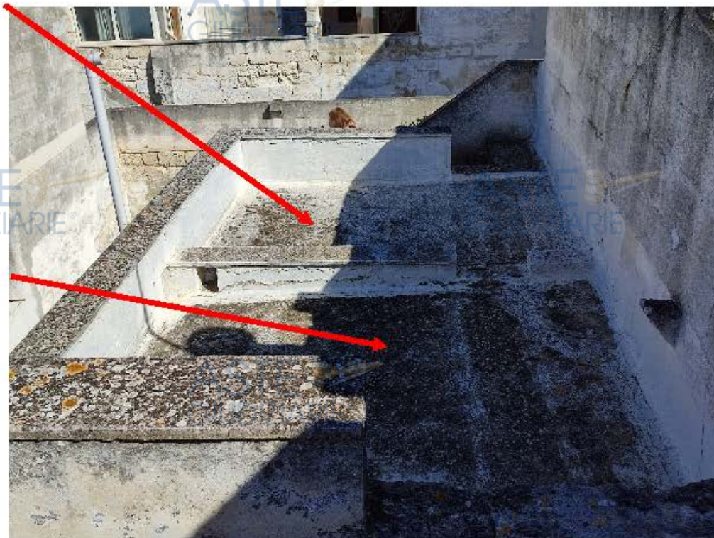
Lastrico di copertura del bagno e della cucina
