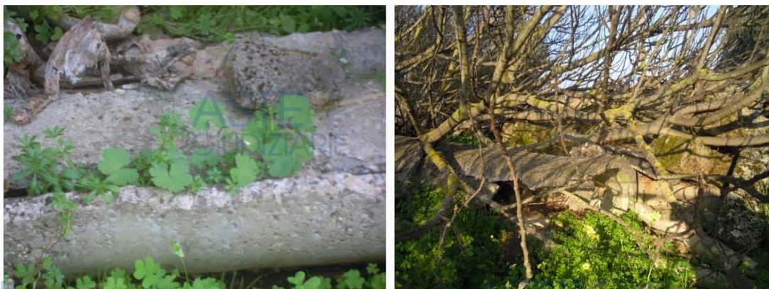
Fig. 57 e Fig. 58: Foto delle canalette - Particolari
