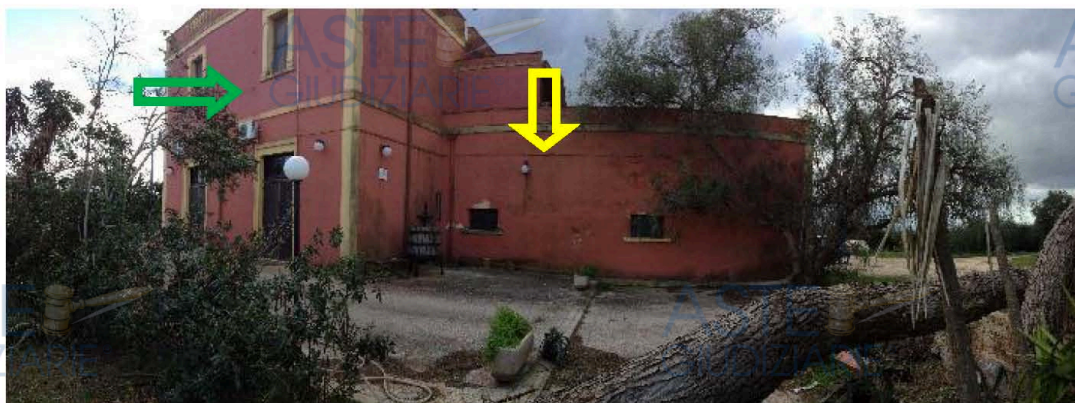
Fig. 11 - La freccia verde e la gialla indicano rispettivamente le unità immobiliari adibite a residenza (fabbricato 1) e a deposito (fabbricato 2)
