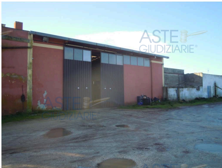
Fig. 25) Foto dell'esterno dell'unità immobiliare adibita a deposito e uffici (fabbricato 3)
