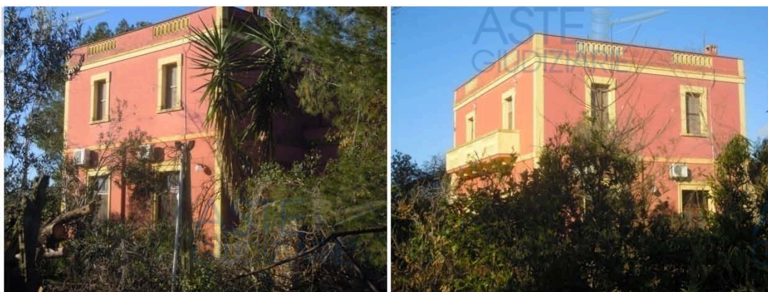
Fig. 12) e fig. 13) Foto dell'esterno dell'unità immobiliare adibita a residenza (fabbricato 1)
