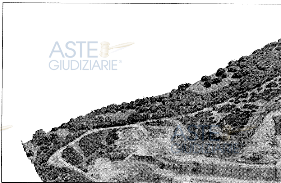
Stralcio fotografico dell'area interessata - Volo Drone
