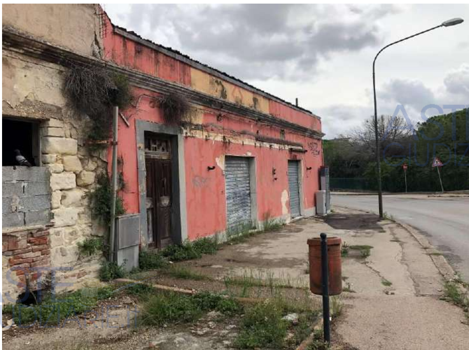
Immagine 12. Immagine del fabbricato con accessi dalla via Bellini
