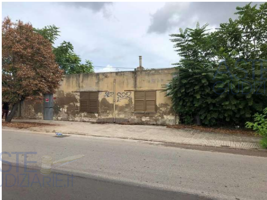
Immagine 16. Lo stesso fabbricato di cui all'immagine precedente, ripreso da altra angolazione.
