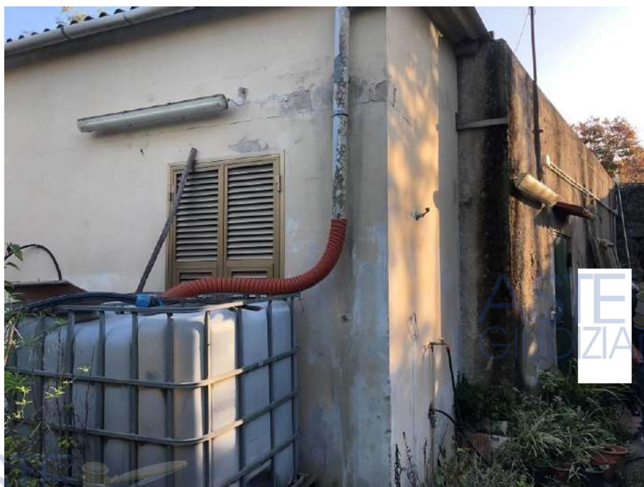
Immagine 17. Il fabbricato di cui all'immagine precedente, ripreso dal retro.
