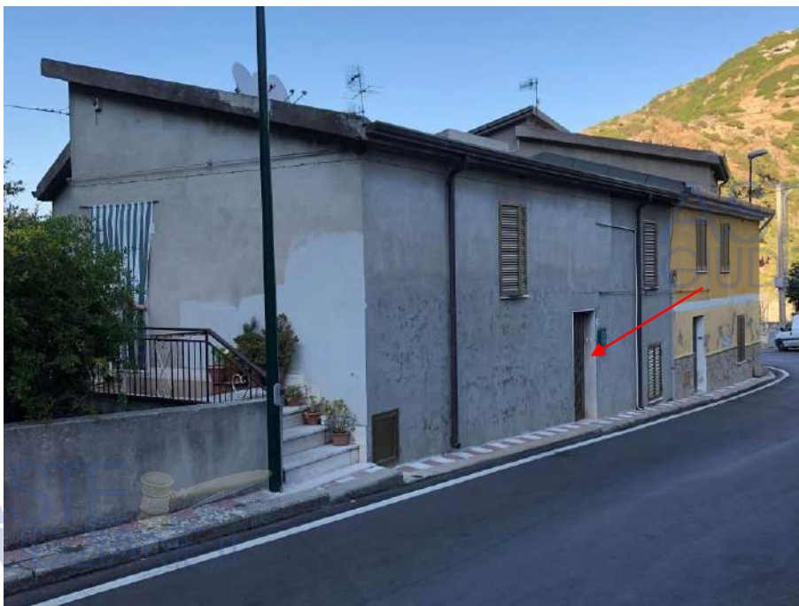
Immagine 1. Il fabbricato in Loc. San Lorenzo Via Gruppo Chiesa n.8; l'accesso dell'unità immobiliare al piano terra avviene dal portoncino sul marciapiede
