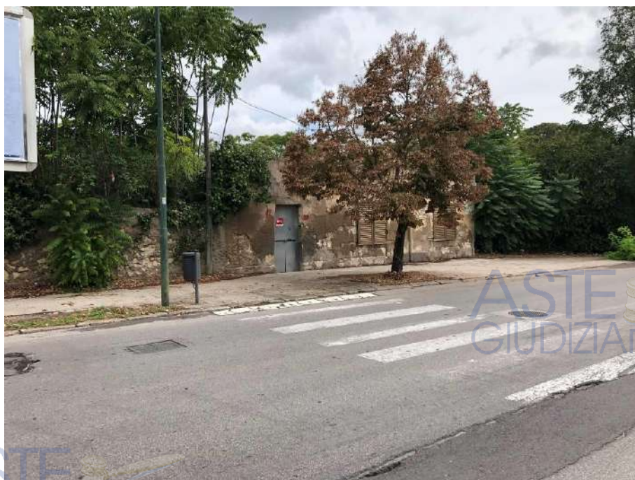
Immagine 15. Immagine di un altro fabbricato del lotto con accessi dalla via Bellini
