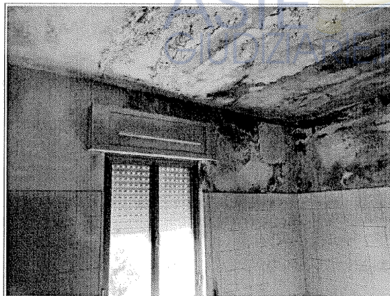
Foto – particolare della zona più colpita dalle infiltrazioni
