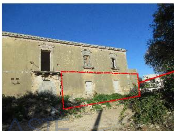
lato a sud-est – foto del 14.01.2023
