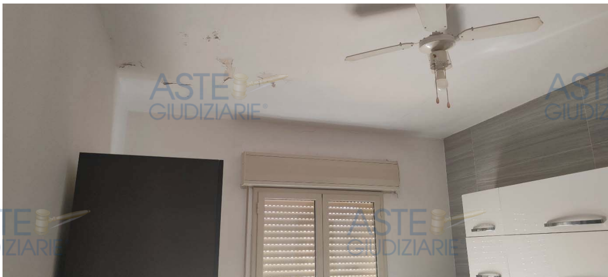
Foto 5: infiltrazioni di umidità solaio vano cucina/locale sottotetto
