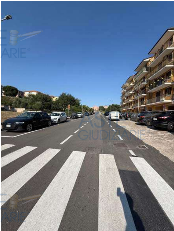
Strada di accesso al fabbricato
