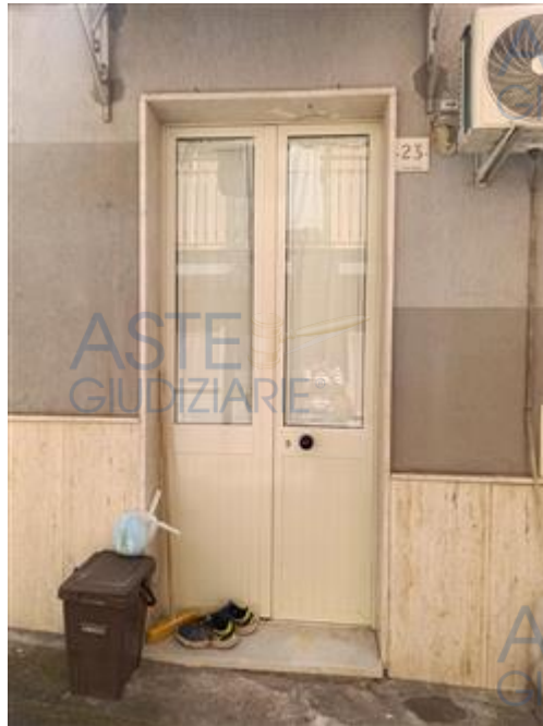
Vista della porta-finestra della cucina
