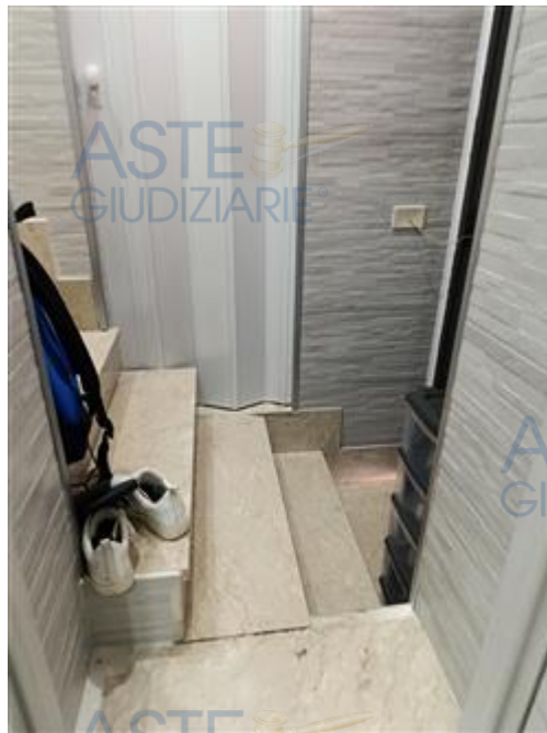
Vista del collegamento interno
