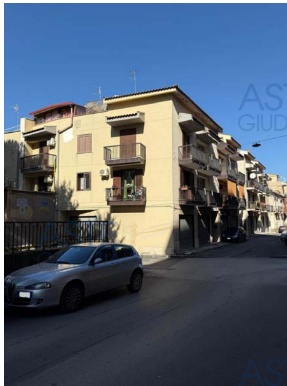
Vista esterna del fabbricato in cui l'immobile è ubicato
