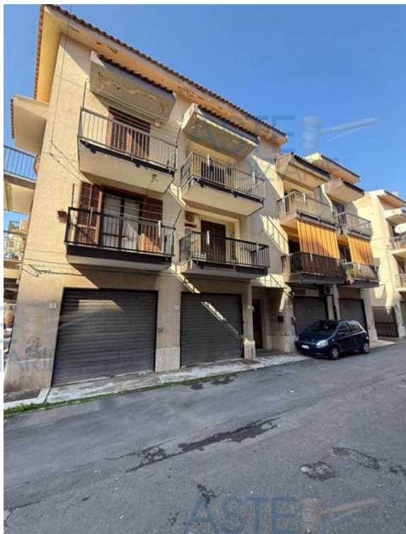
Vista esterna del fabbricato in cui l'immobile è ubicato
